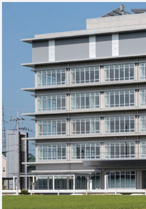
▼新庁舎の各階に「日除け用ひさし」を設け、夏の冷房エネルギーを節約。
